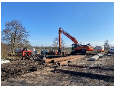
Figuur 3. De damwanden worden geplaatst voor de bouwkuip voor het gemaal.
