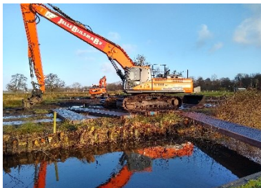
Figuur 2. Op diverse plekken zijn rijplaten neergelegd.
