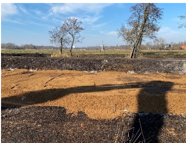
Figuur 6. Het ijzerzand is aangebracht (lichtbruine grond).
